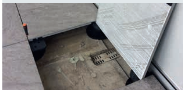
Après le déverrouillage, le support est accessible
